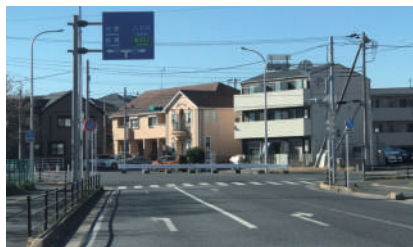
一部工事完了後の幕弁線幕張中学校付近。
