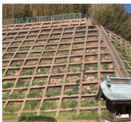
工事完了後の急傾斜地。
